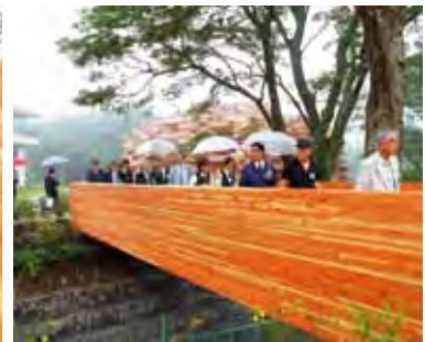
長さ11メートルの木橋は、ネットの森と同じ大断面集成材が用いられている。
